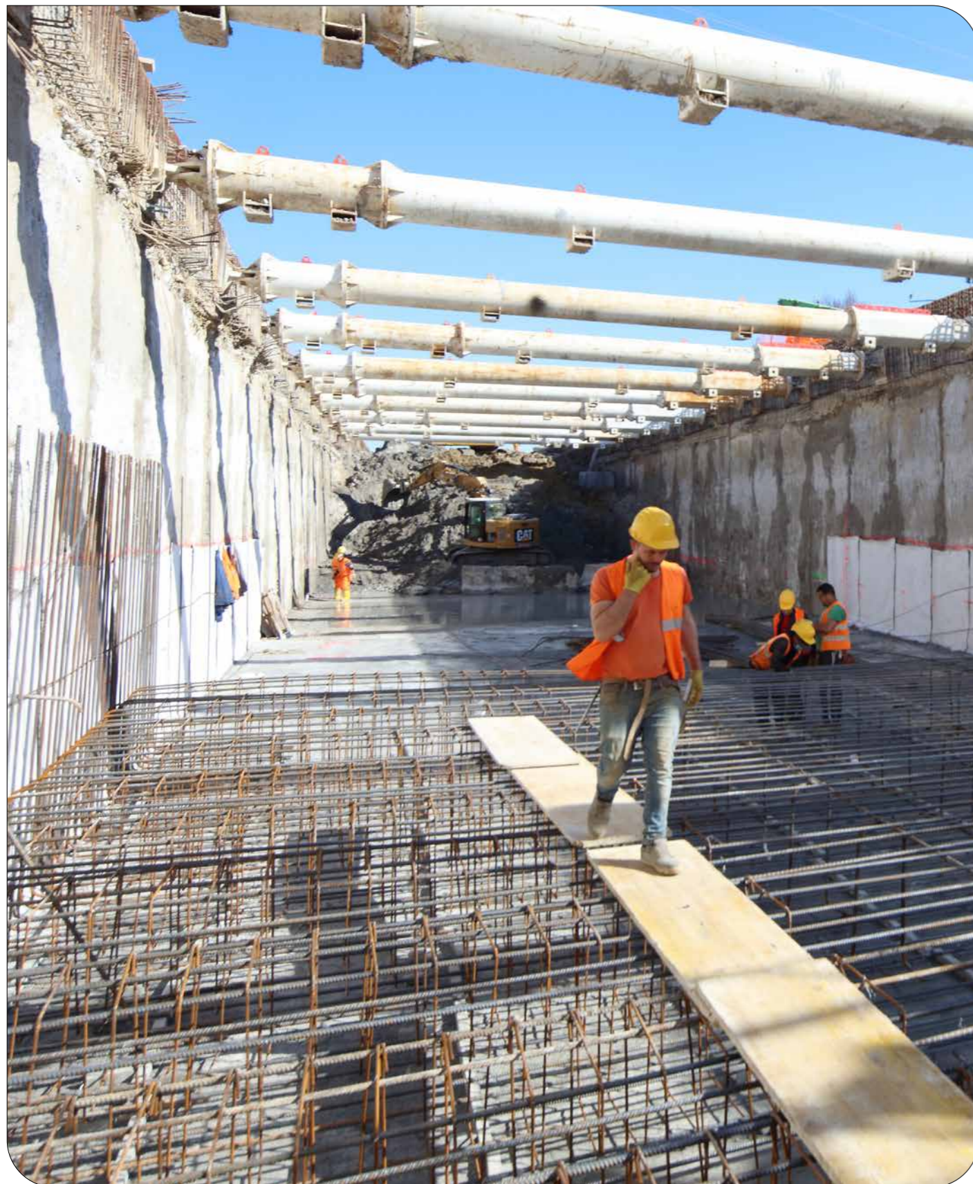
Tangenziale di Pordenone
