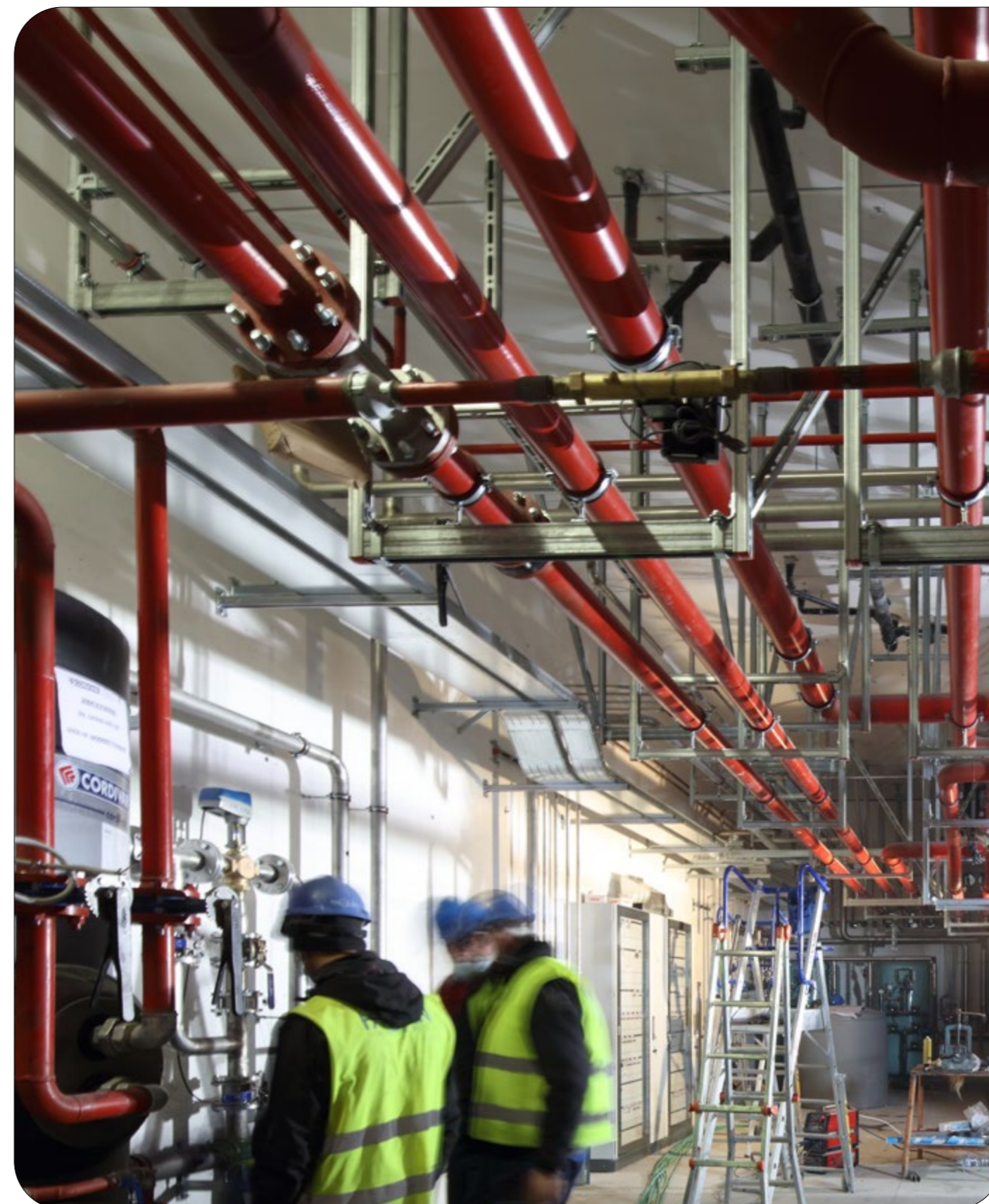
📷 Verifiche sugli impianti dell'Ospedale di Pordenone
